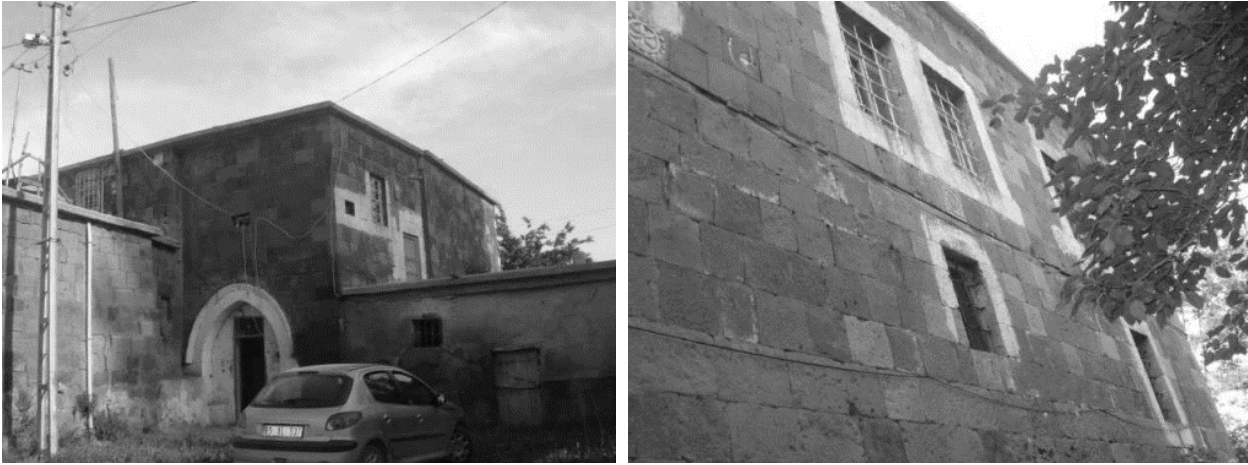
Figure 40. Mahmut Aksüt House Photos (Karakuş, 2008)
