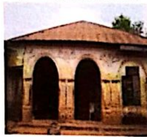
b). Wall and Door Ornament
